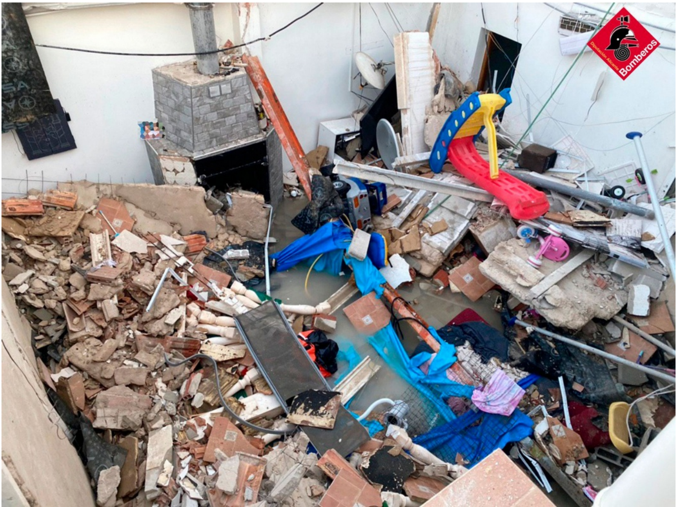
Imagen de los destrozos.
