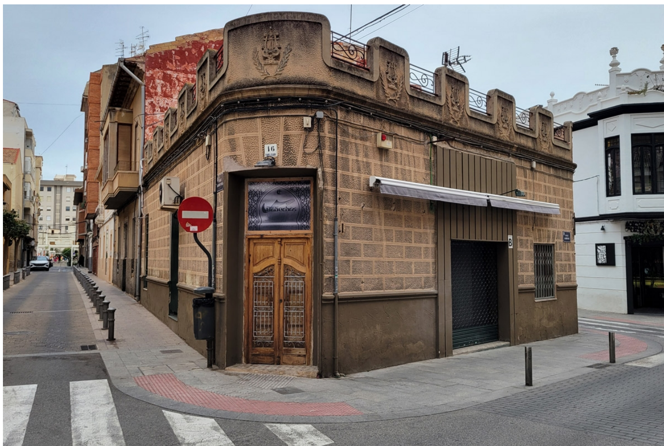
Vivienda de Francisco Santos Amat en la calle Jardines, nº 22
