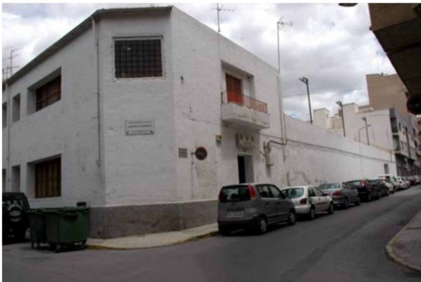
Locales en la calle Conde Coloma donde estuvieron enclavados los almacenes de SICEP
