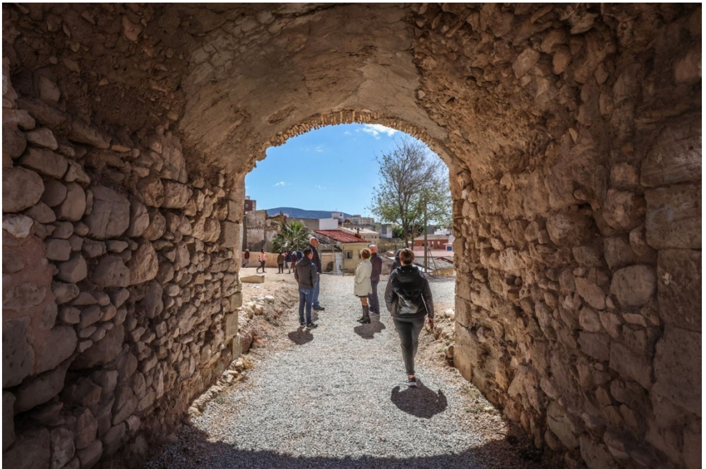
La barbacana será restaurada en esta intervención.
