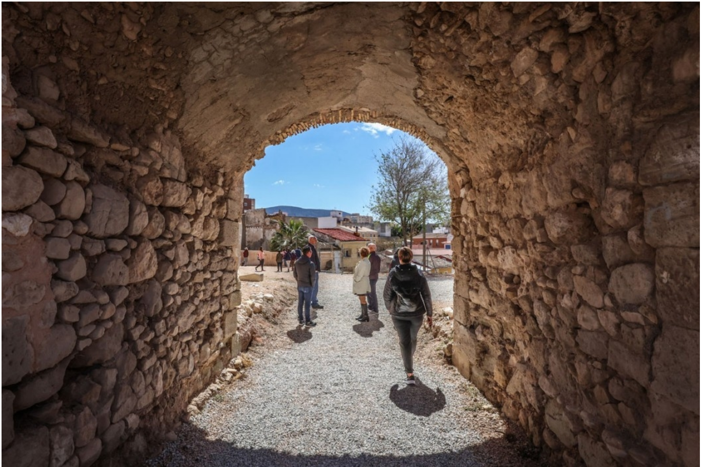
La barbacana será restaurada en esta intervención.
