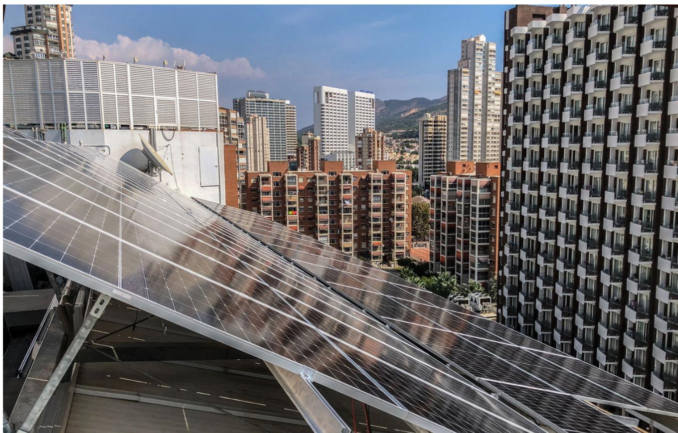
La instalación de placas tiene importantes ayudas.
