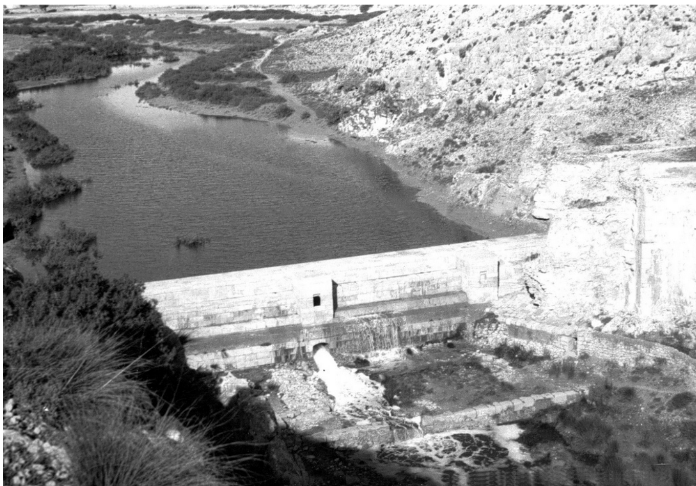
Vista del pantano de Elda a finales de la década de los años 60, en la que se puede observar a la derecha de la foto el gran estribo perteneciente a la presa construida en 1684 y destruida en 1793.
