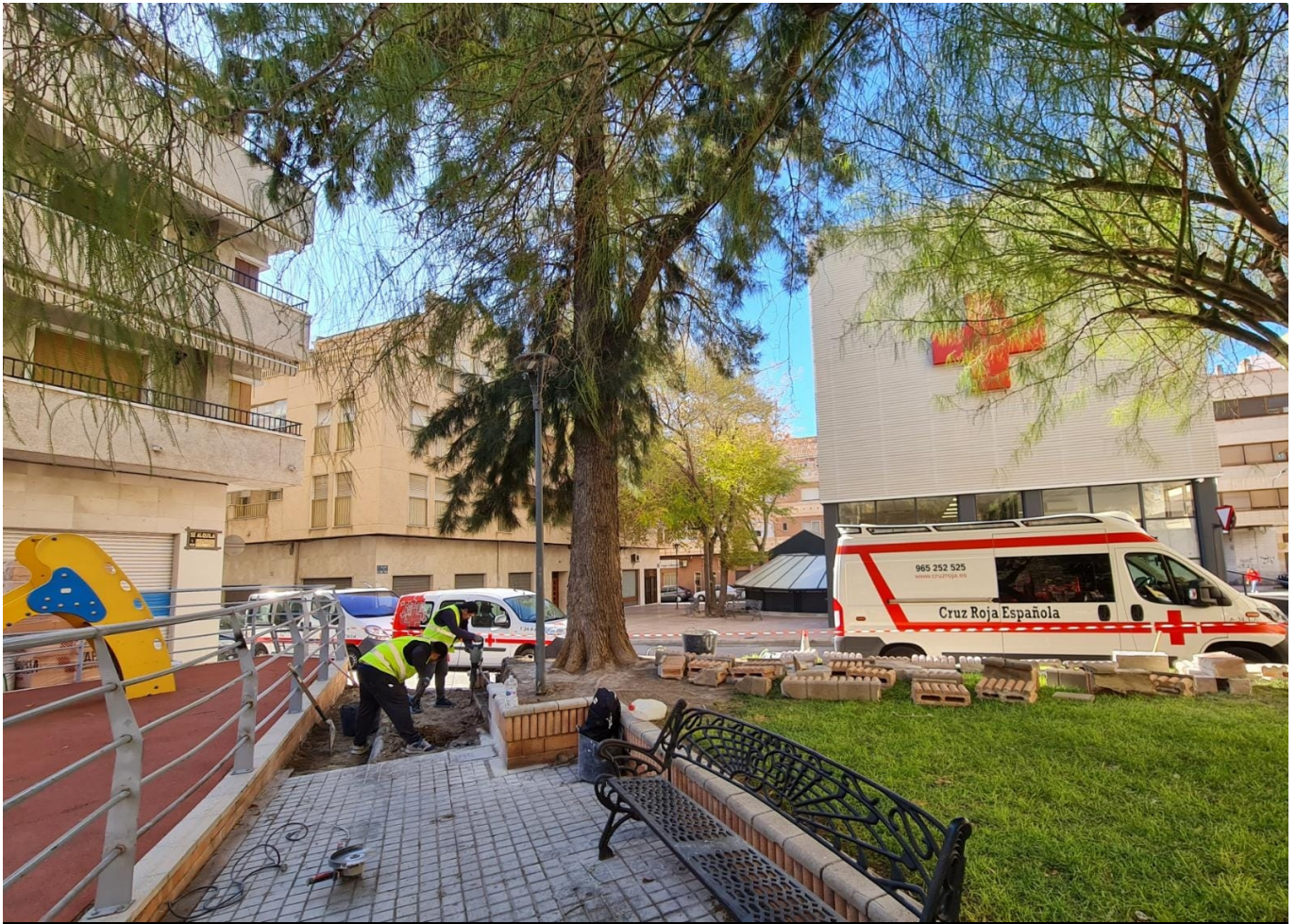
Imagen de las obras.
