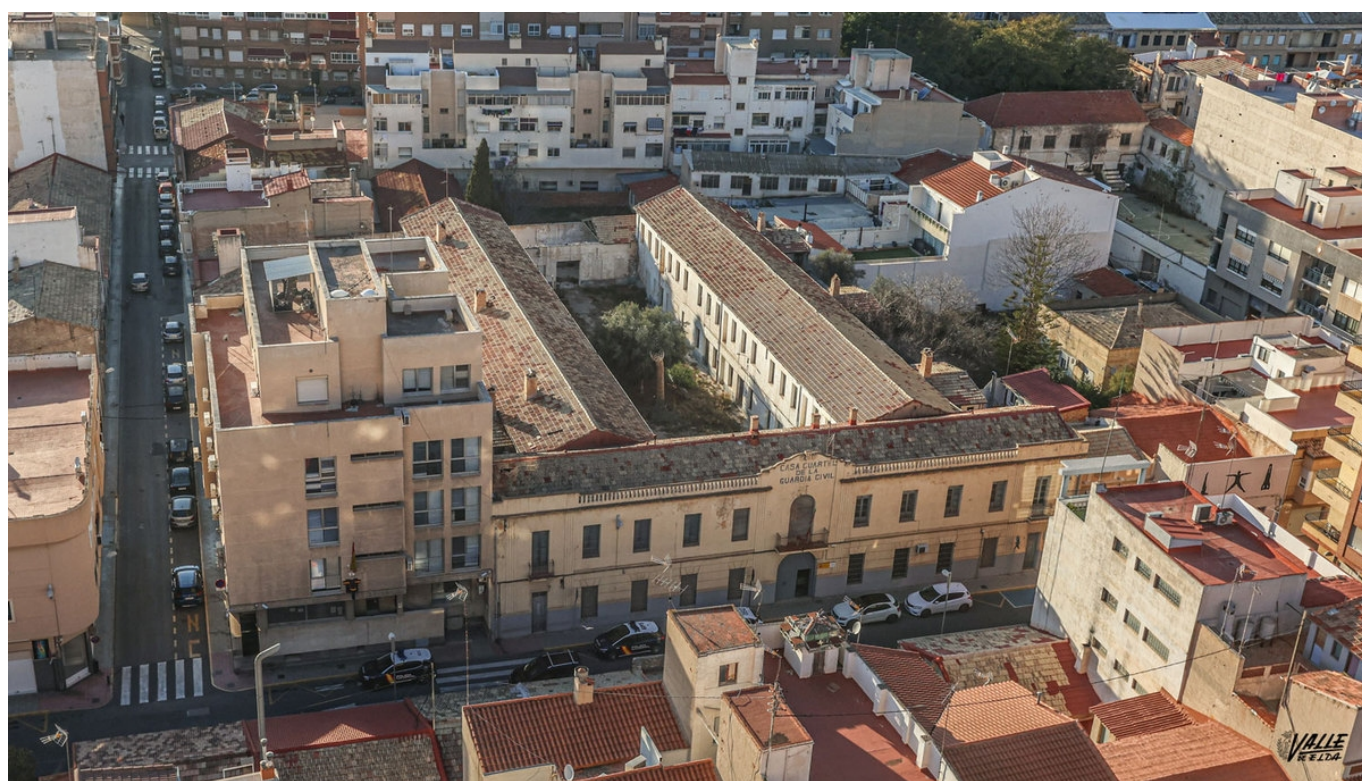
Imagen aérea del Cuartel de la Guardia Civil de Elda.
