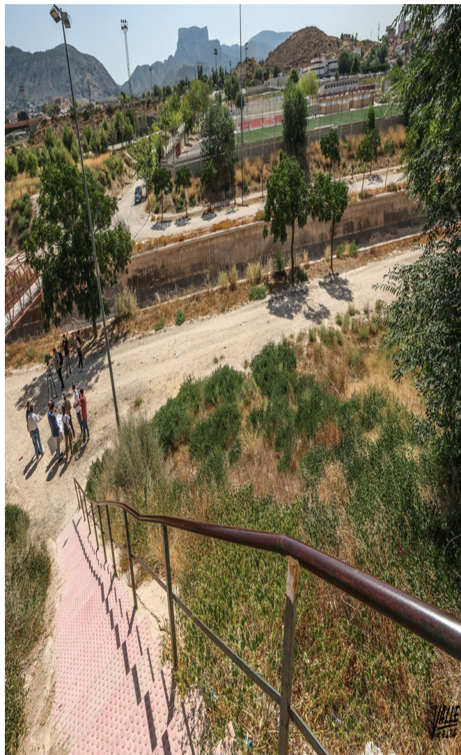
Las actuales escaleras de la Huerta Nueva se verán sustituidas por rampas en los próximos meses
