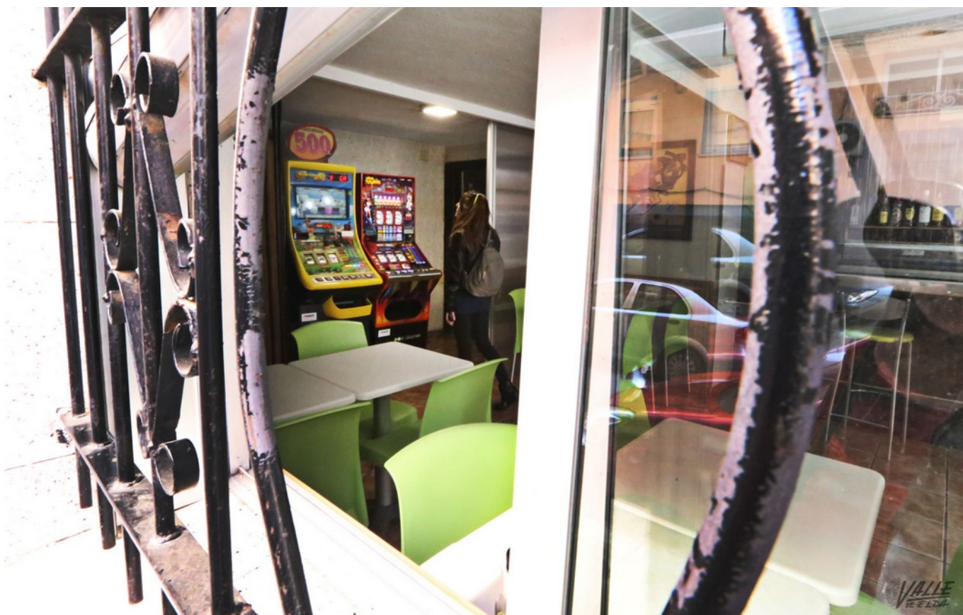
La ventana del bar ha sido forzada con el gato hidráulico | Jesús Cruces
