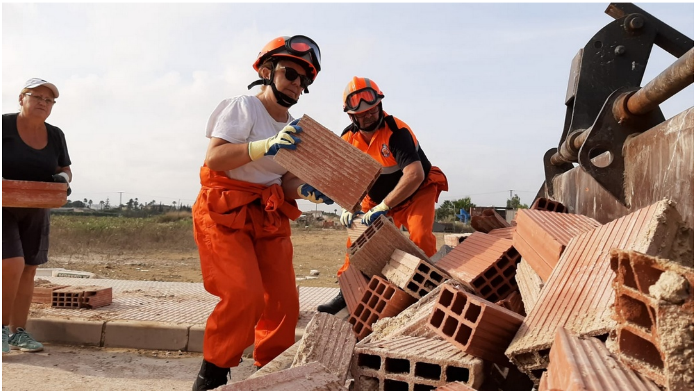
Voluntarios de Protección Civil Elda haciendo tareas de limpieza.
