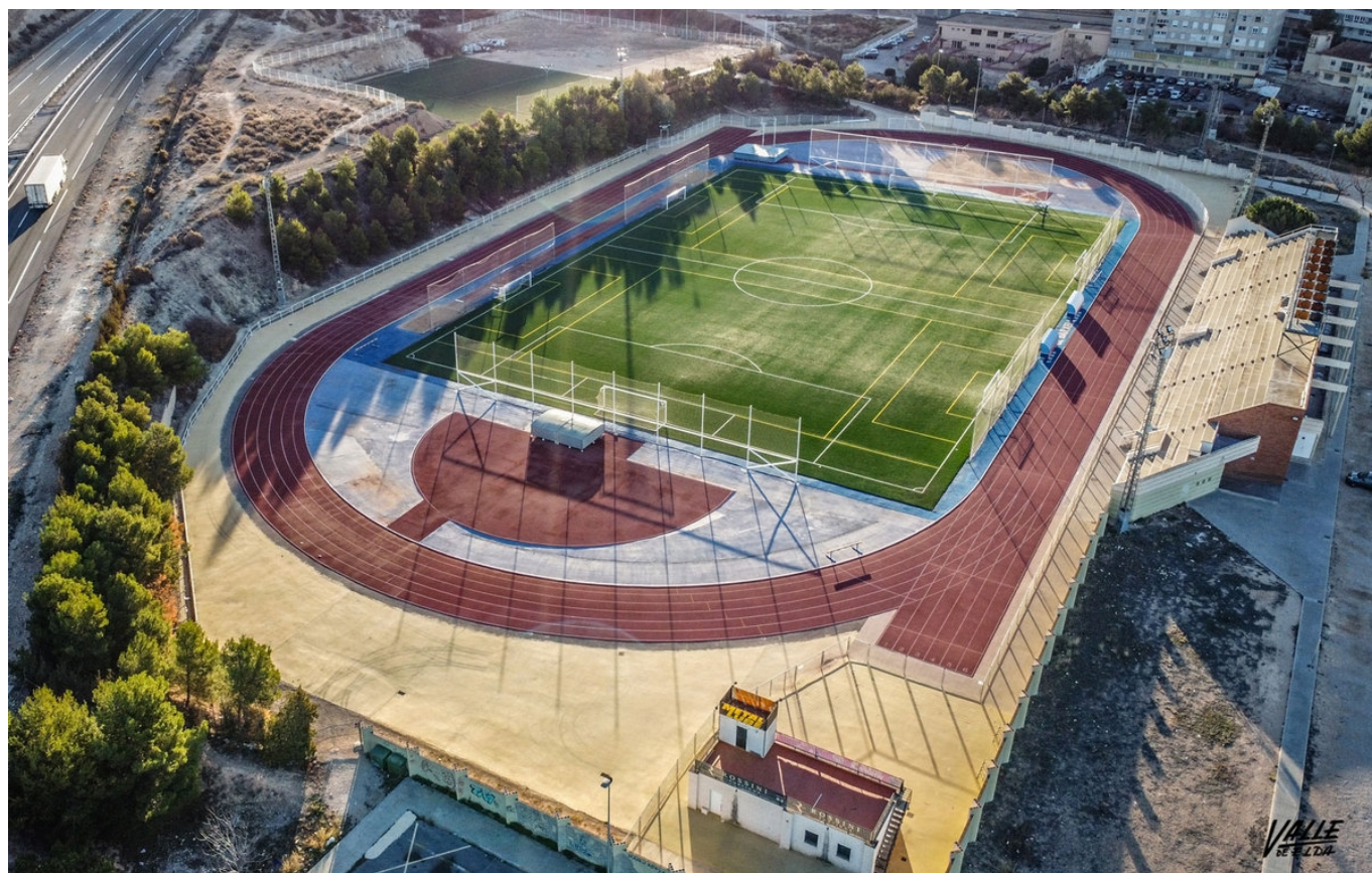
Imagen de las instalaciones de El Barxell | J.C.
