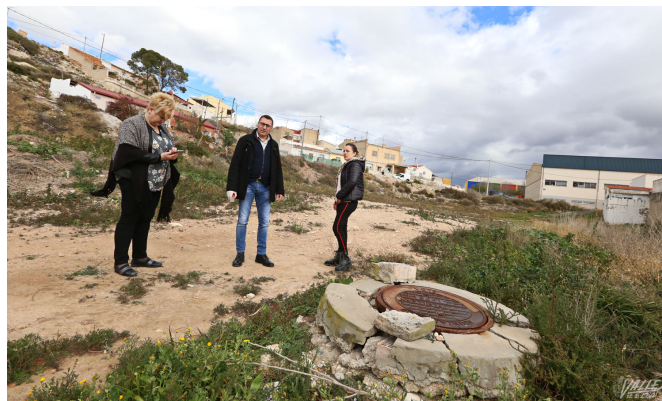
El partido también pide que se repare un alcantarillado roto | Jesús Cruces.
