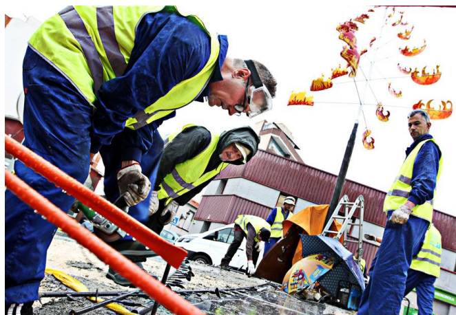
Los trabajadores instalan el monolito bajo la lluvia | Jesús Cruces
