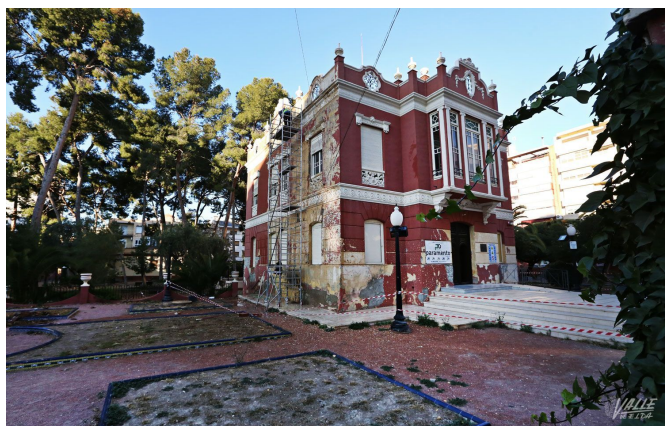
El avance de las obras se ve a simple vista | Jesús Cruces.
