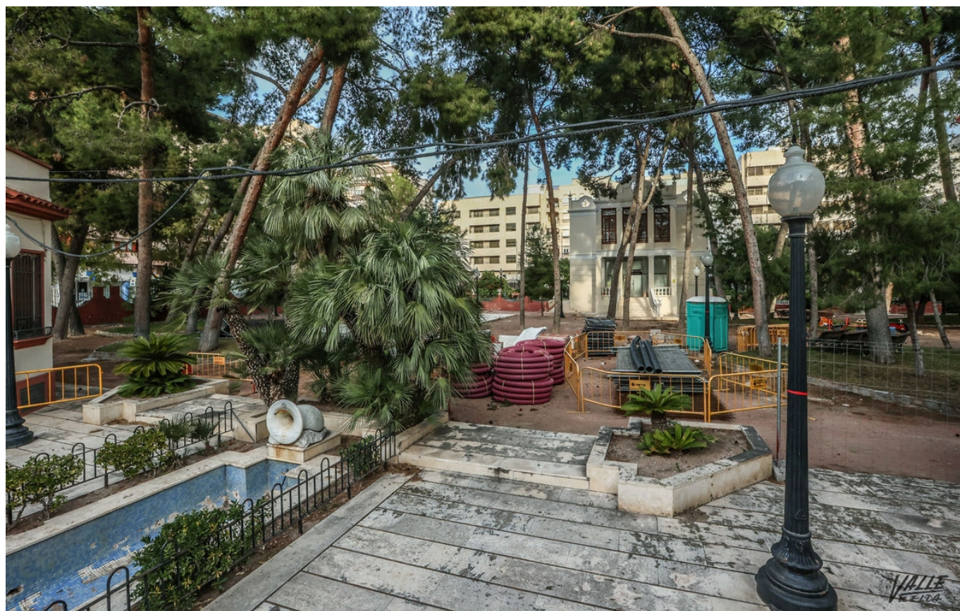
Los trabajos han comenzado en el Jardín de la Música | J.C.
