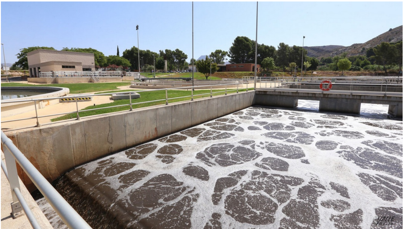
Imagen de la Depuradora de aguas situada en Elda.
