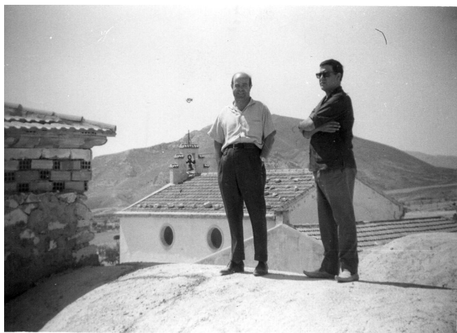
Pedro Gras (izquierda) de visita a las obras de los depósitos de agua potable de San Crispín (1963)
