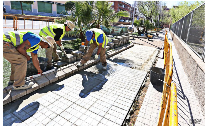
Se está reparando la acera de la calle Santa Bárbara | Jesús Cruces.
