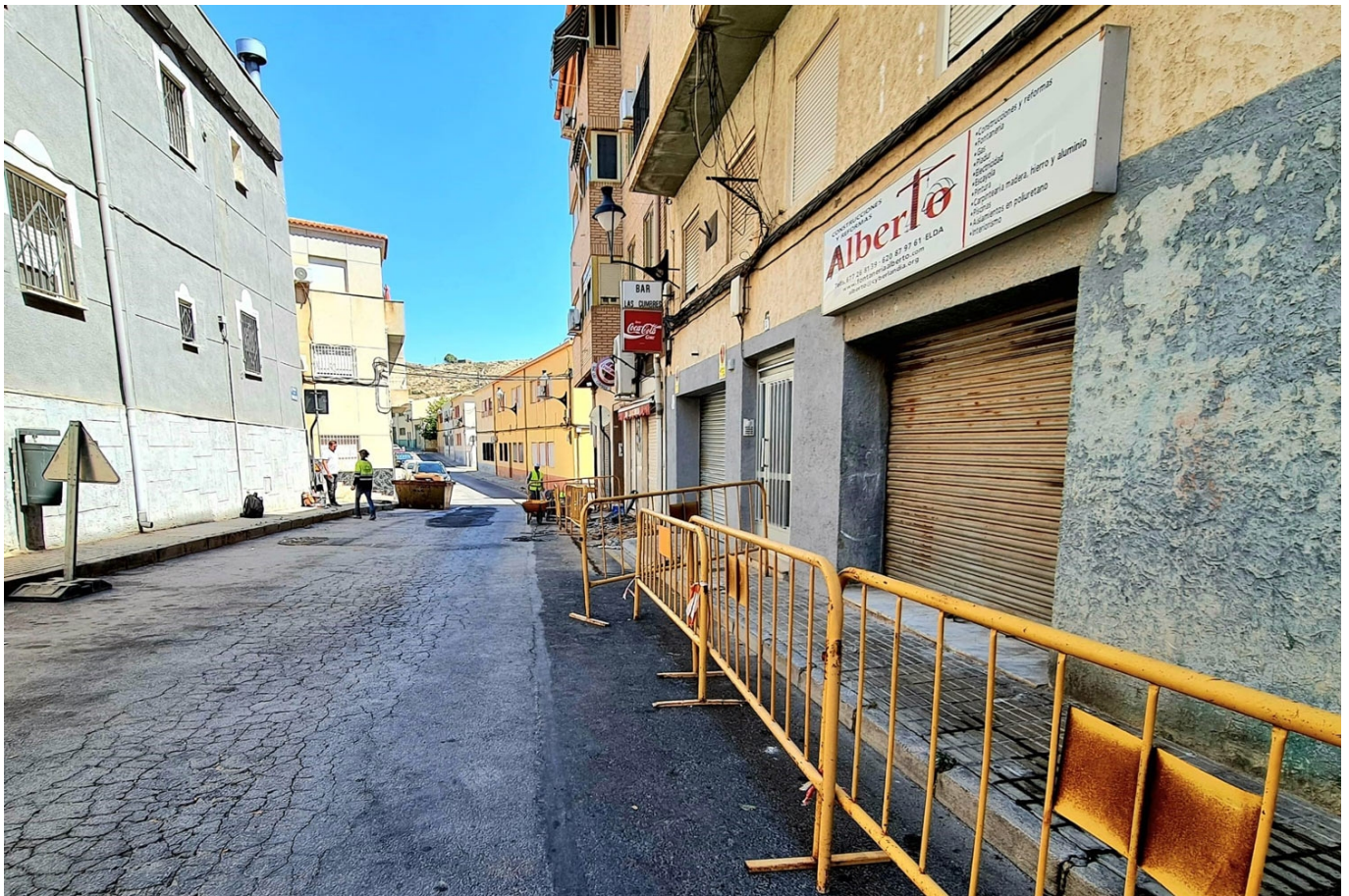
Las obras ya han comenzado en este barrio de Elda.
