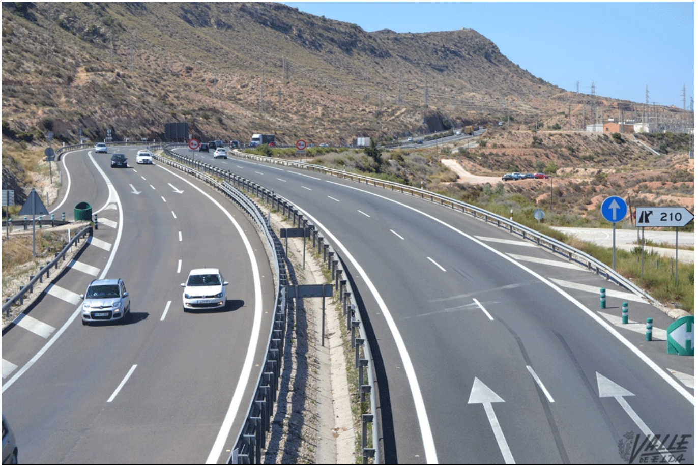
Punto de la autovía A-31 donde se ha producido el accidente | A.J.
