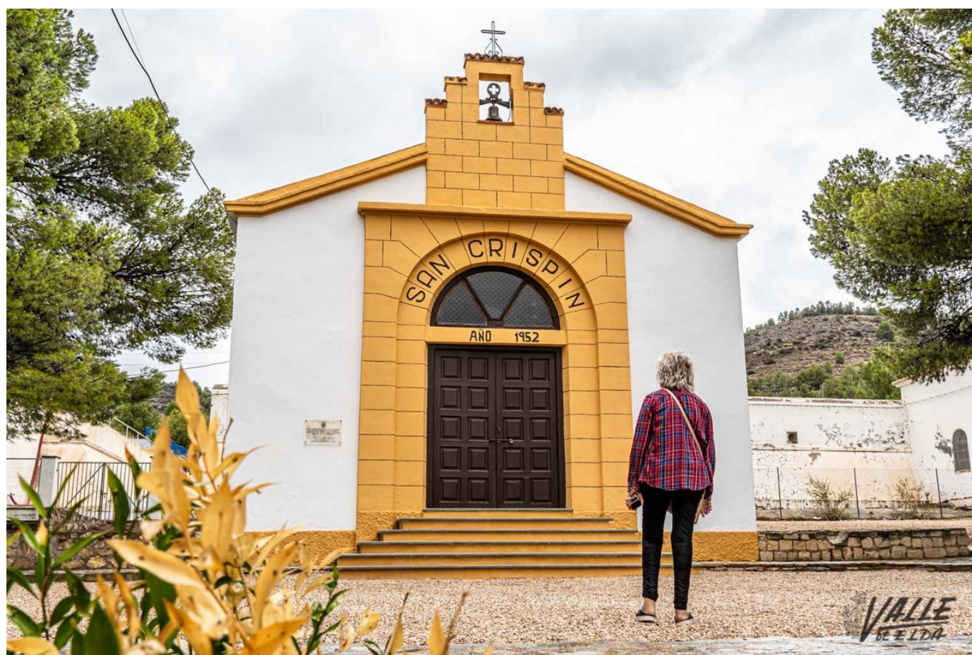
Las obras de la ermita han concluido | Nando Verdú.
