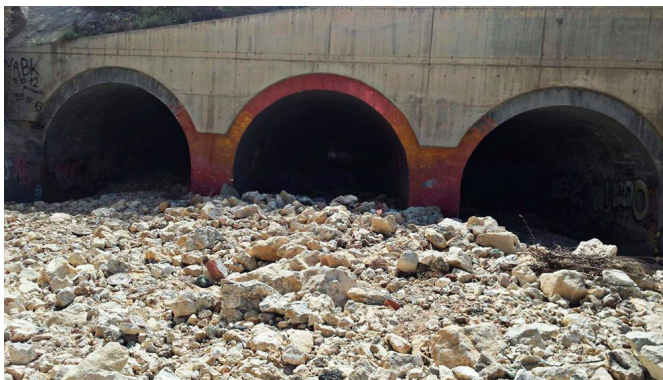
Imagen del túnel previa al trabajo de Manuel.
