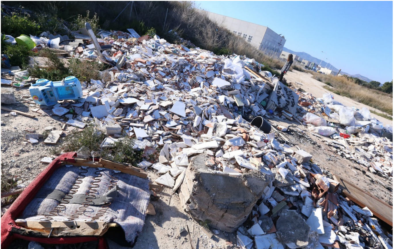
Toneladas de escombros en la esquina de Finca Lacy, junto al circuito de Motocross.
