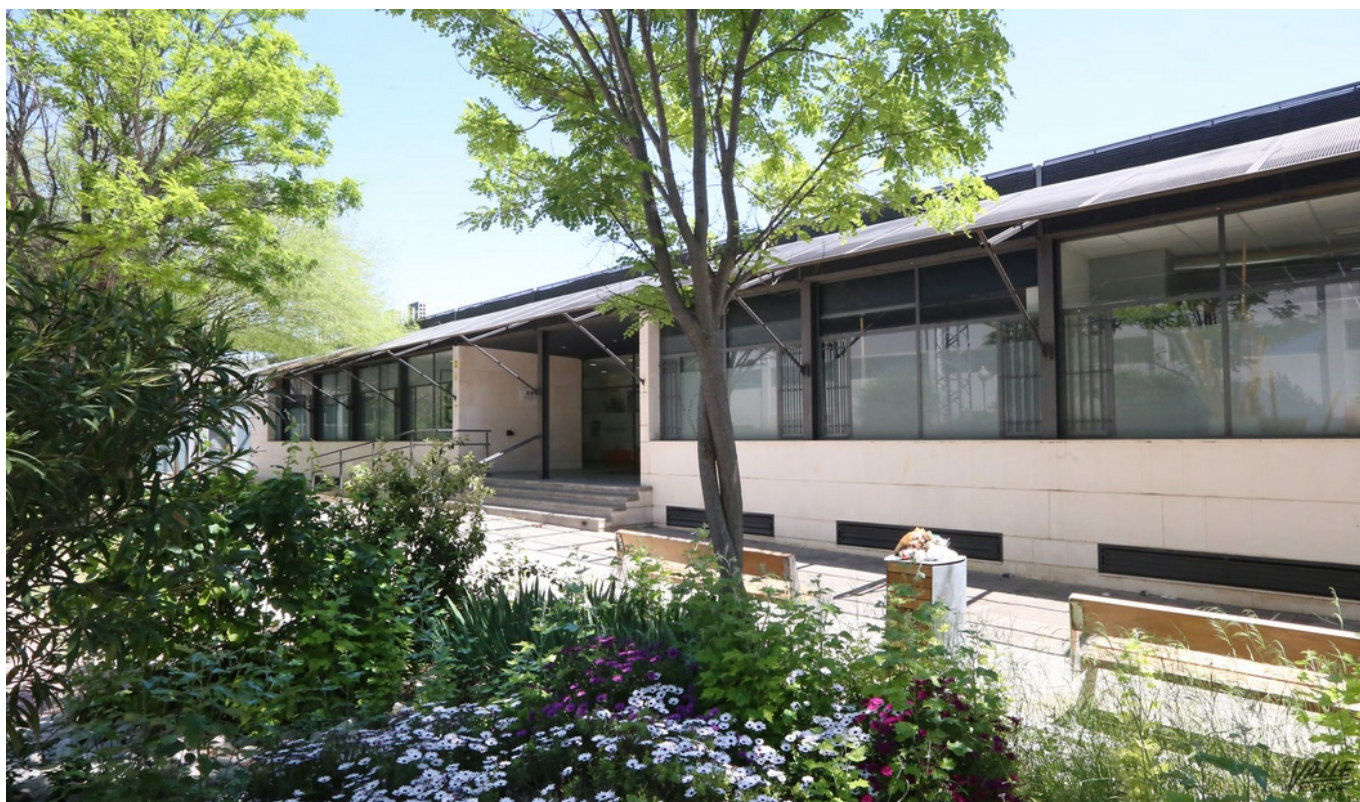
Imagen de las instalaciones de EMUDESА.
