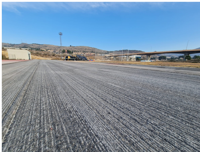
El suelo de la pista se está reformando.
