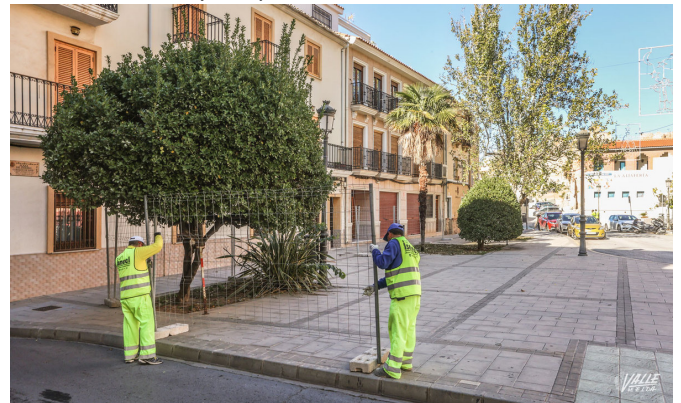
Toda la zona ha sido vallada para el inminente inicio de las obras | J.C.
