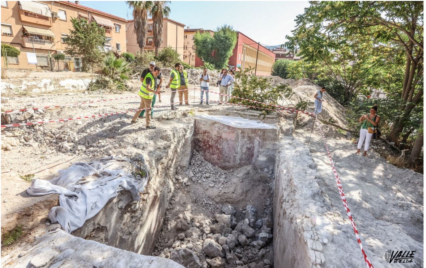
Estos trabajos permiten conocer la historia enterrada de Elda.
