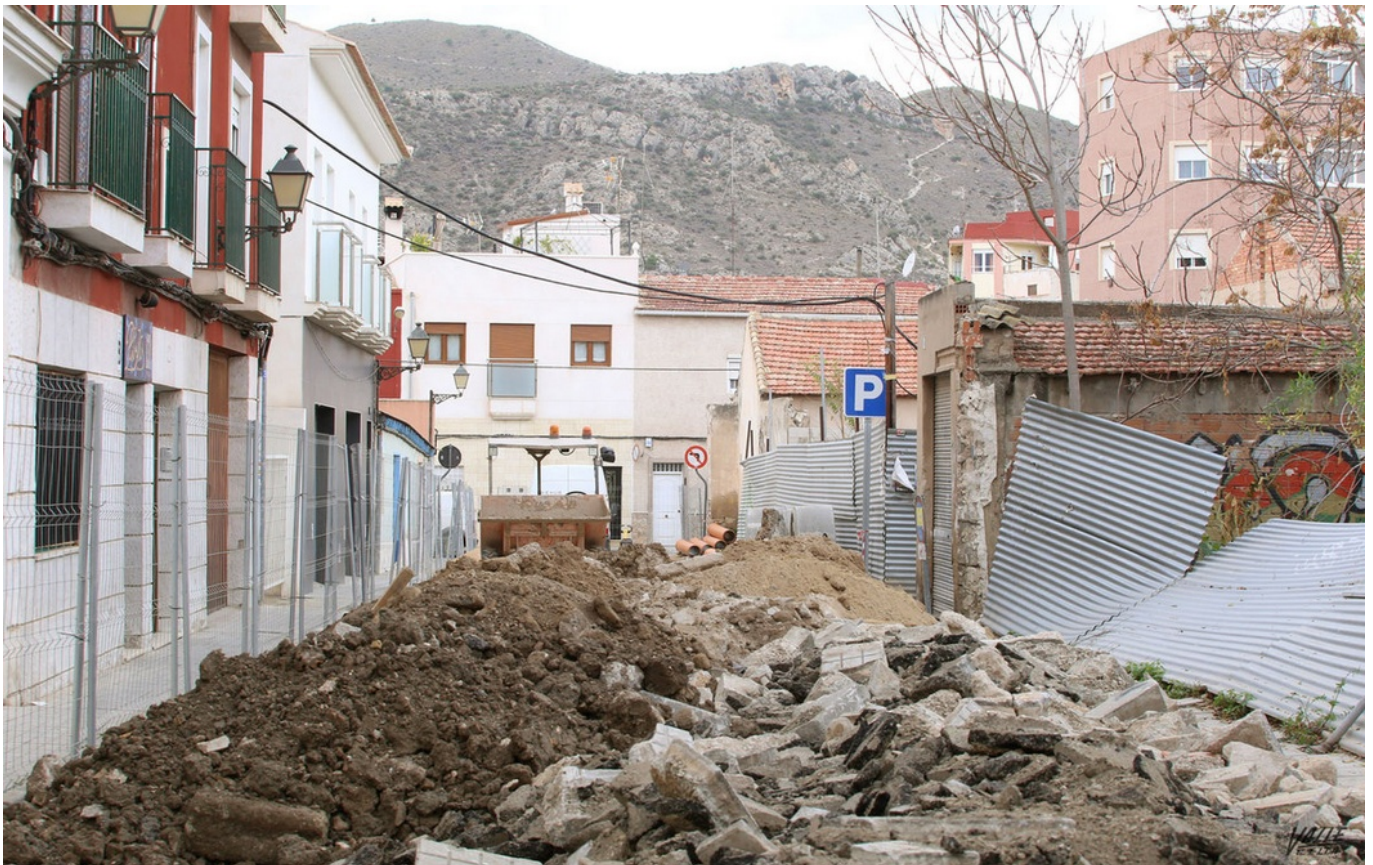
La calle se ha tenido que levantar para realizar la actuación.
