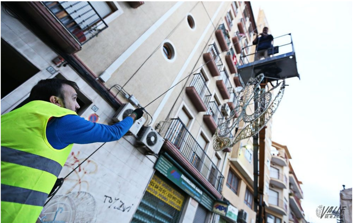
Los trabajos para instalar el alumbrado han comenzado | Jesús Cruces.
