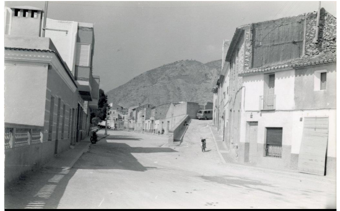
Cruce del Paseo de la Explanada y calle Calvario | José Esteve.
