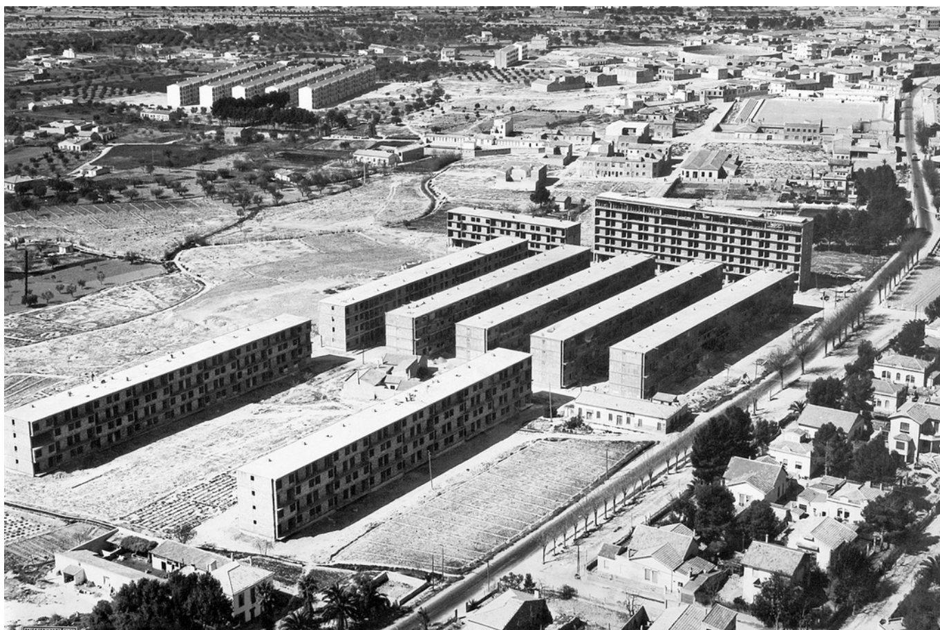
Vista aérea del barrio de San Francisco de Sales, en construcción.
