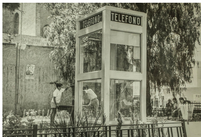
La primera cabina se instaló en 1966 | Carlson.
