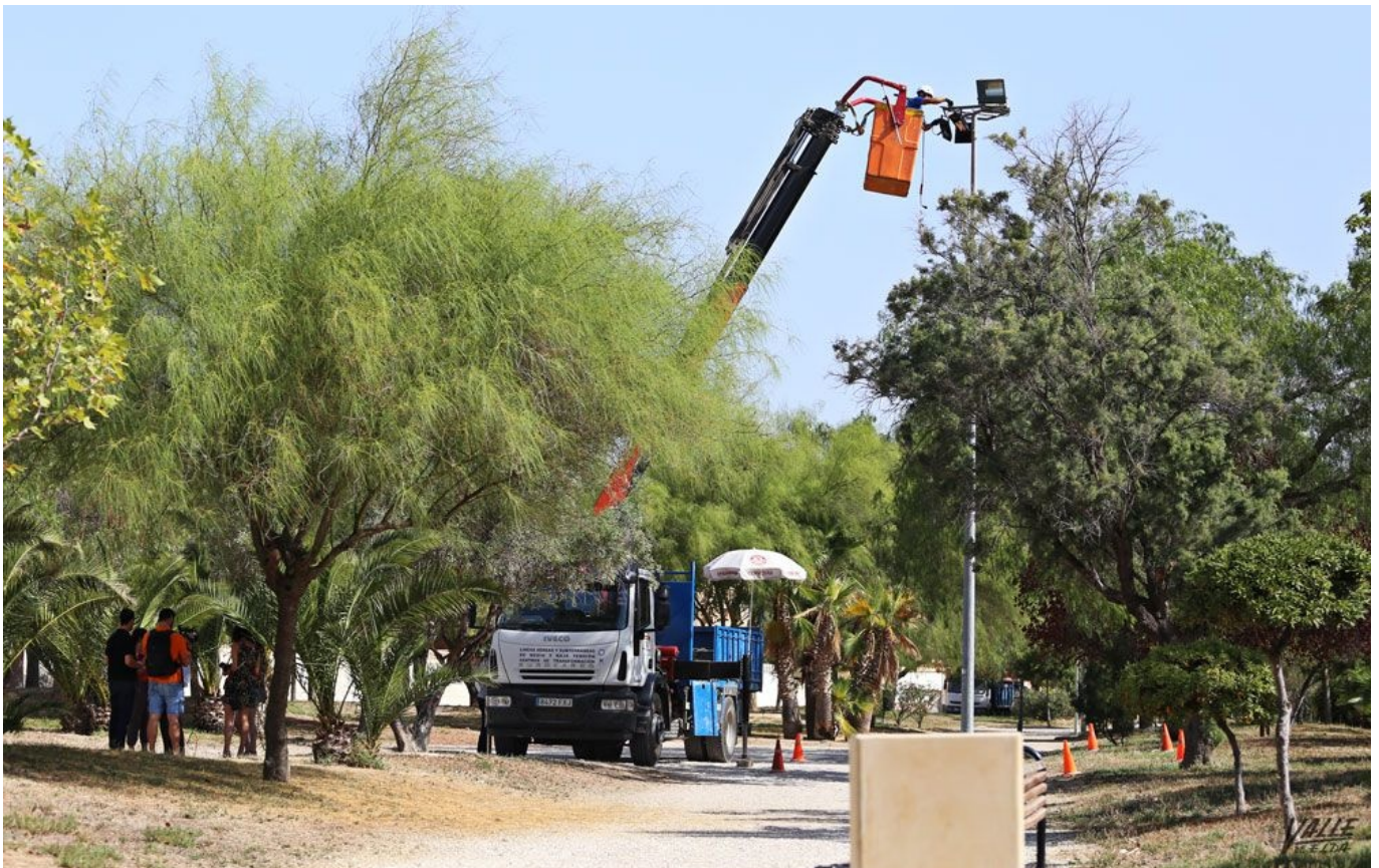
Las obras se estaban realizando esta misma mañana | Jesús Cruces.
