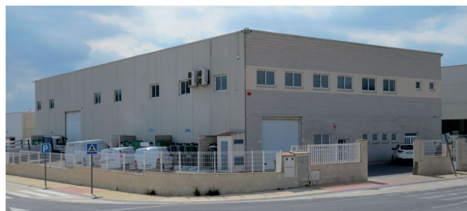
Actualmente la empresa se ubica en el polígono Finca Lacy.
