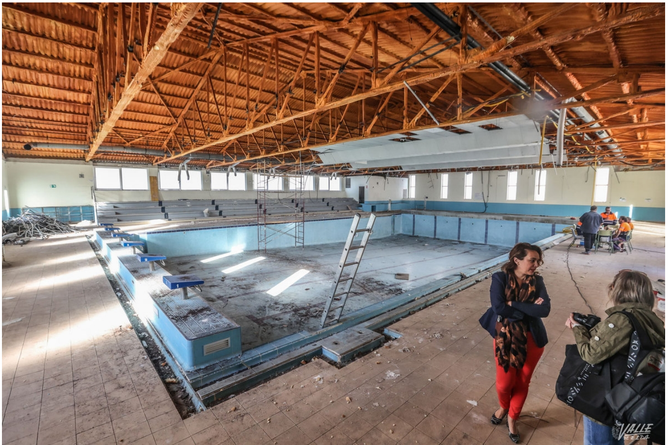
Las obras de la piscina cubierta de San Fernando tienen un plazo de ejecución de 12 meses | J.C.
