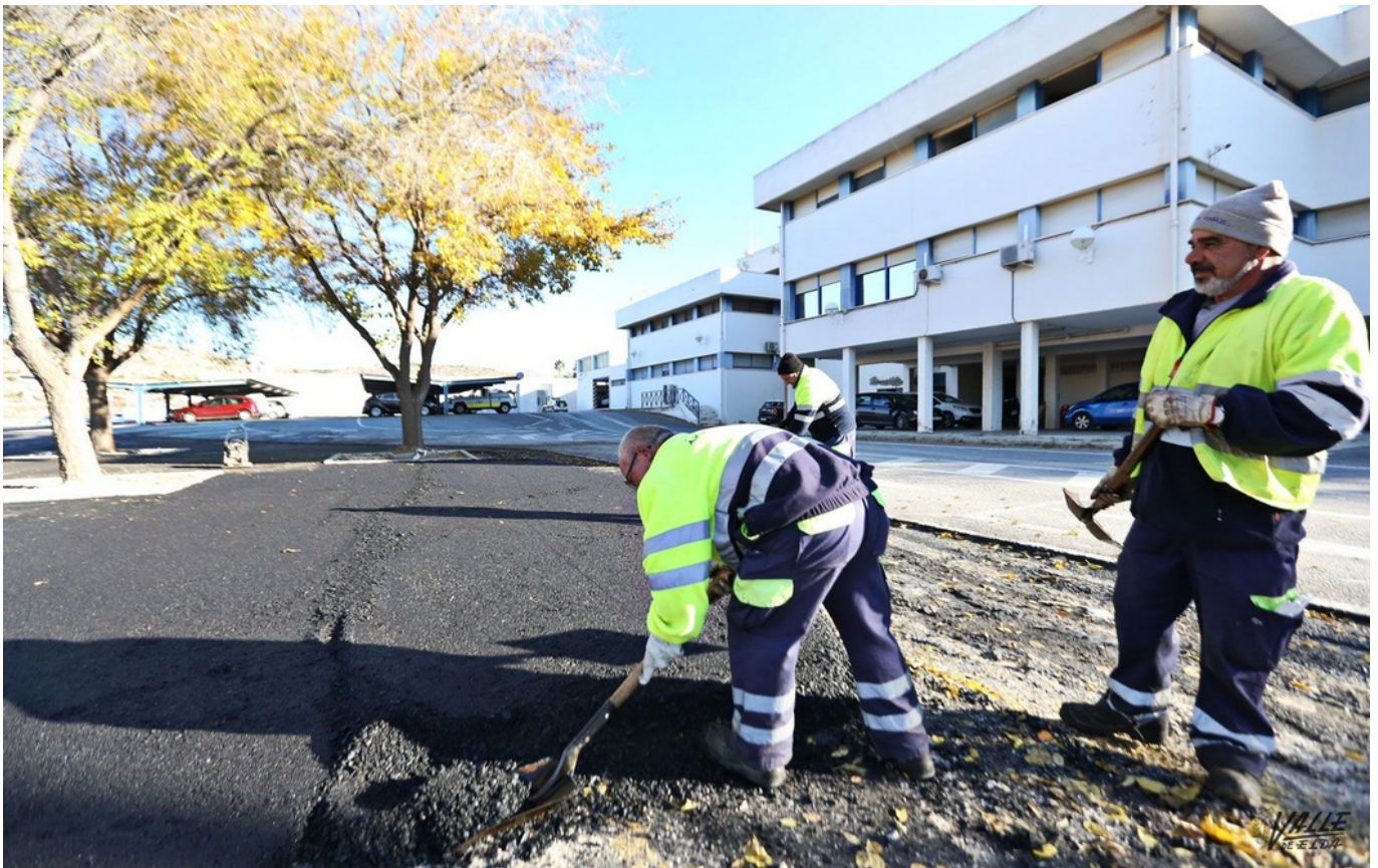
Actualmente se está asfaltando la zona donde irán los vehículos | Jesús Cruces.
