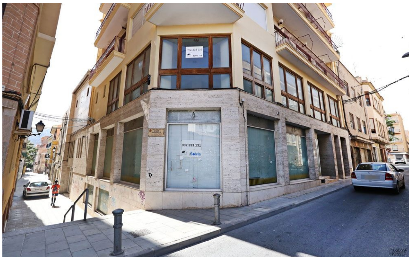
Imagen actual del espacio en el que estaba ubicada la Caja de Ahorros del Sureste de España | Jesús Cruces.
