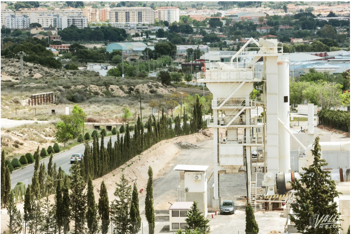
Imagen de la planta asfáltica que se está construyendo en Elda.
