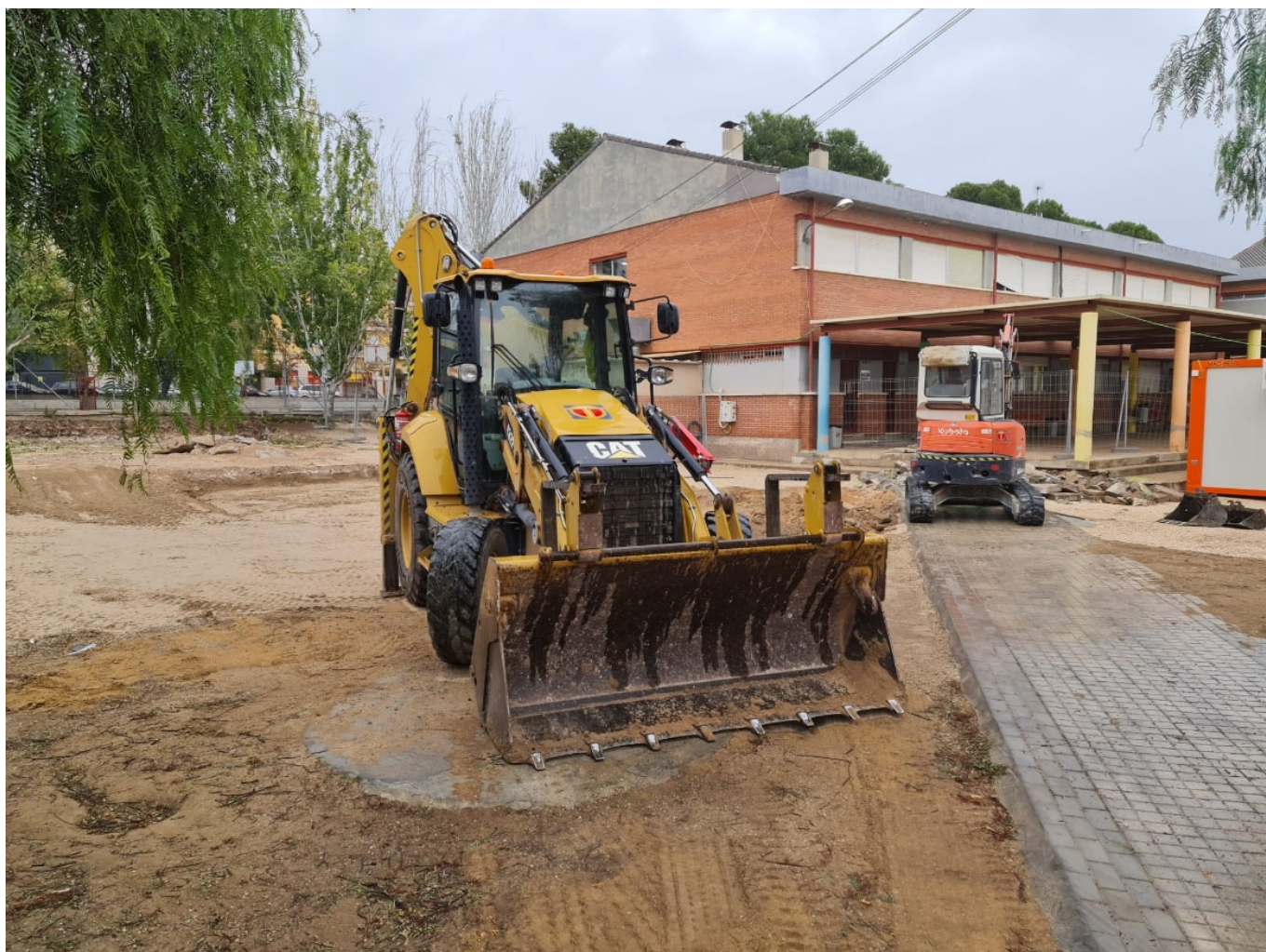
Las obras empezaron la semana pasada.
