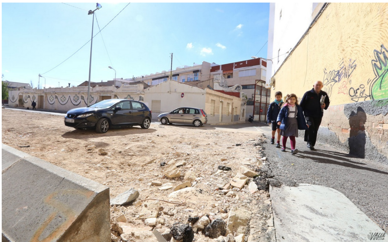
Imagen del solar en el que ya se ha derribado parte del edificio | Jesús Cruces.
