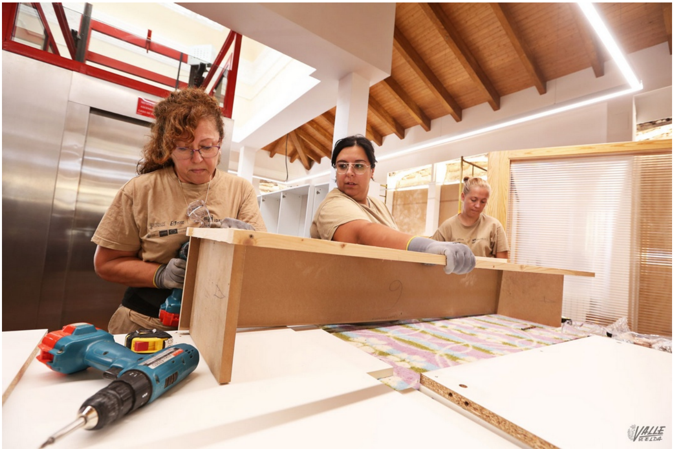
El Taller de empleo está realizando los trabajos de carpintería | Jesús Cruces.
