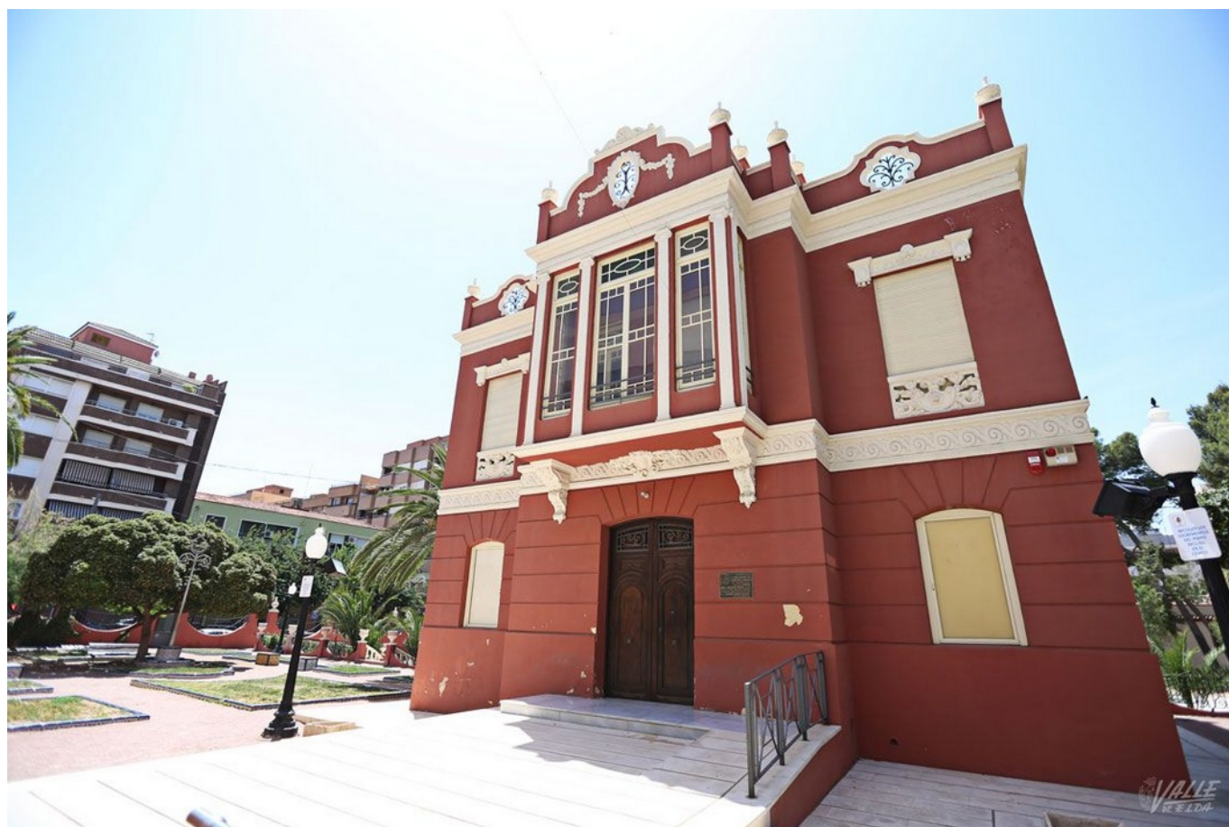
El edificio permanece cerrado hasta su rehabilitación | Jesús Cruces.
