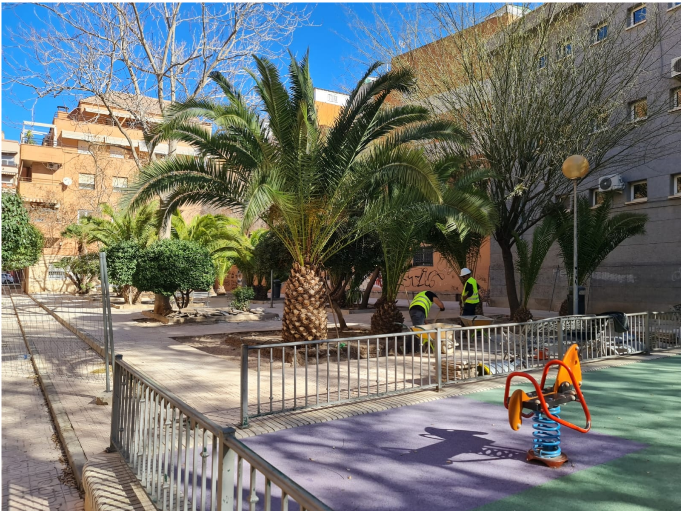
Las obras han comenzado en esta plaza.
