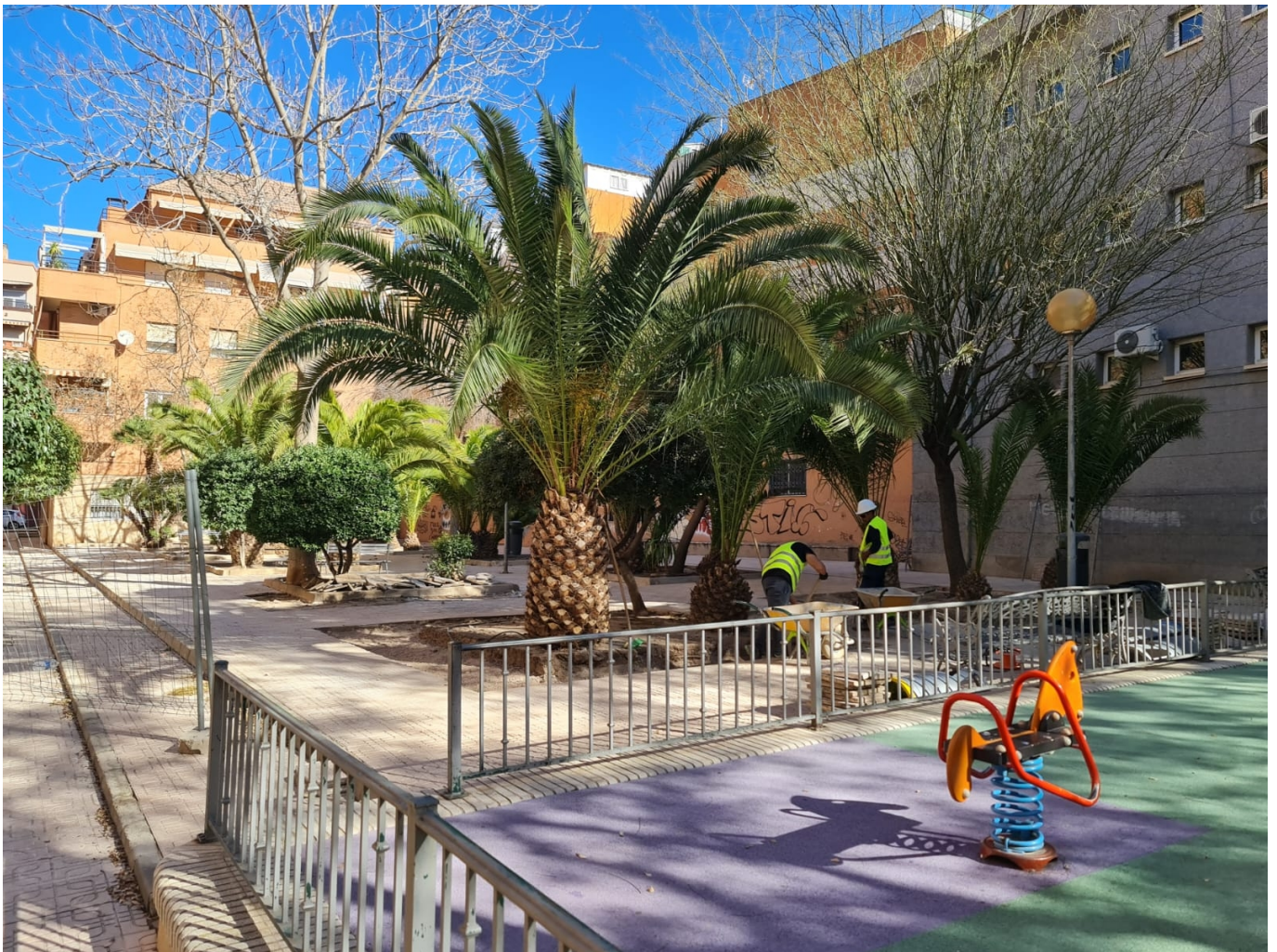
Las obras han comenzado en esta plaza.
