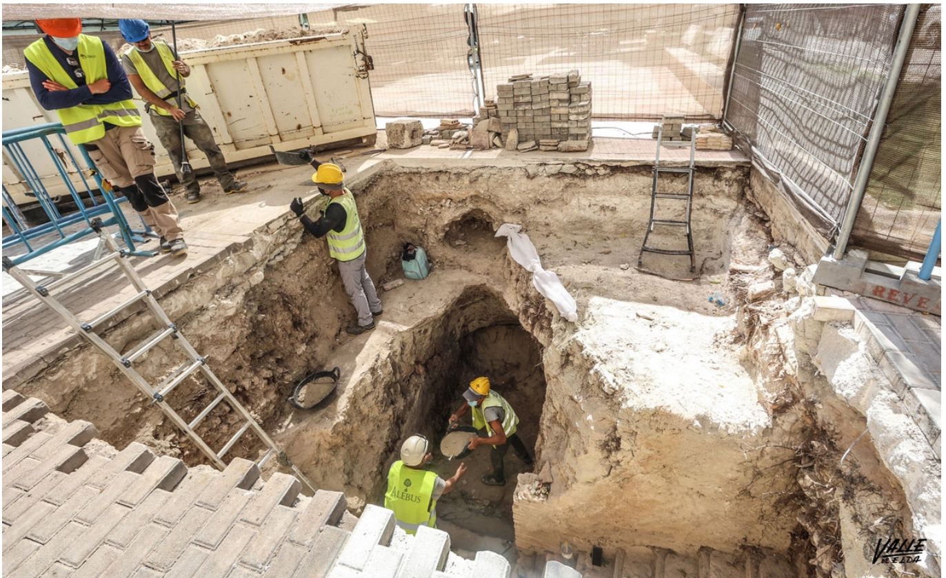
Los trabajos continúan ahora a mano.
