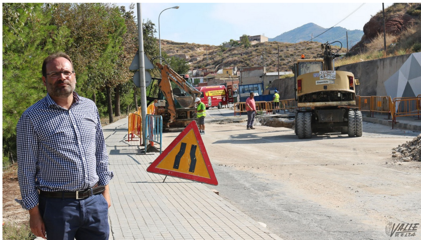
Vicente ha anunciado el inicio de las obras del Paseo de la Mora.
