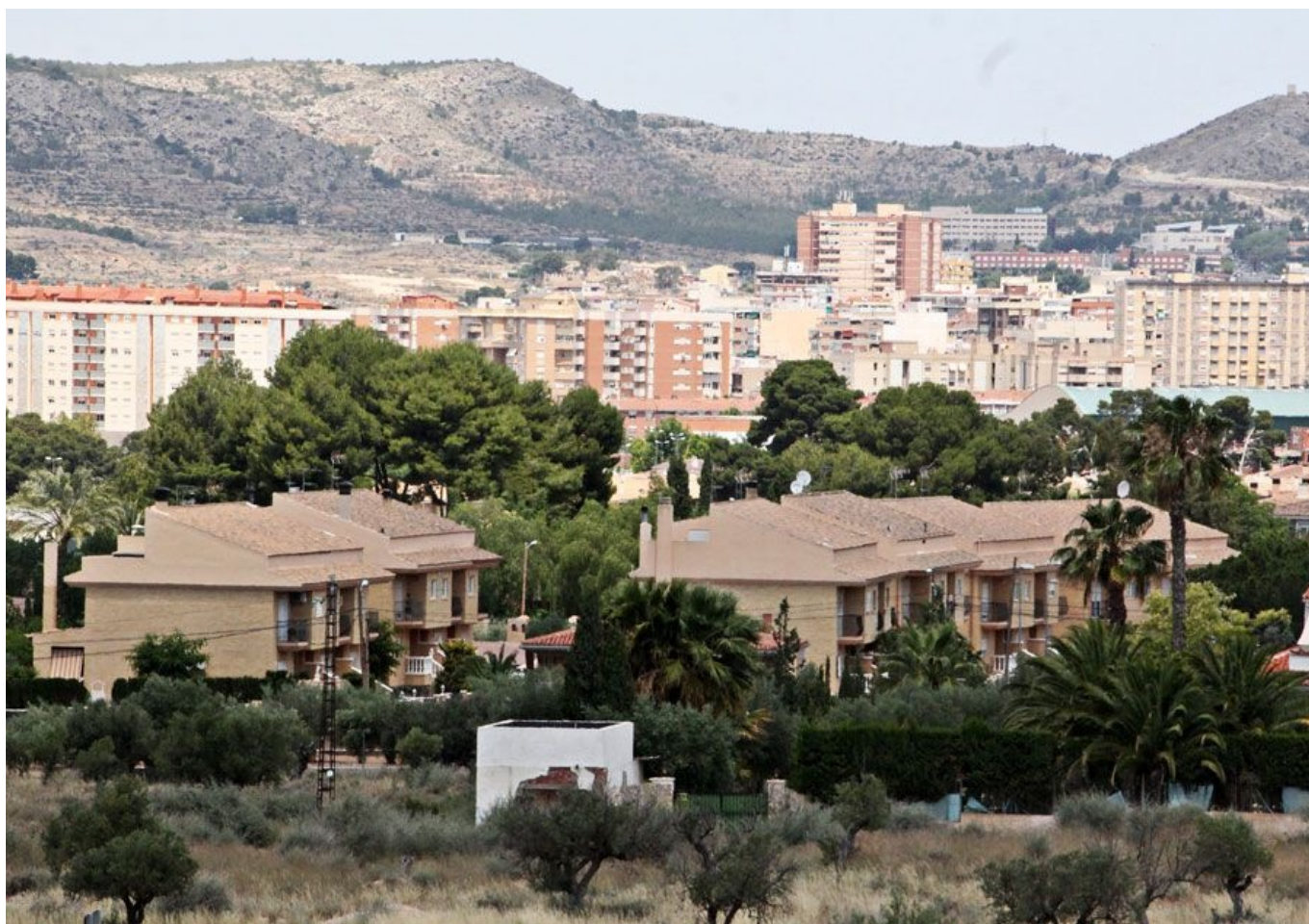
Una orden de derribo afecta a unas 120 viviendas | Jesús Cruces
