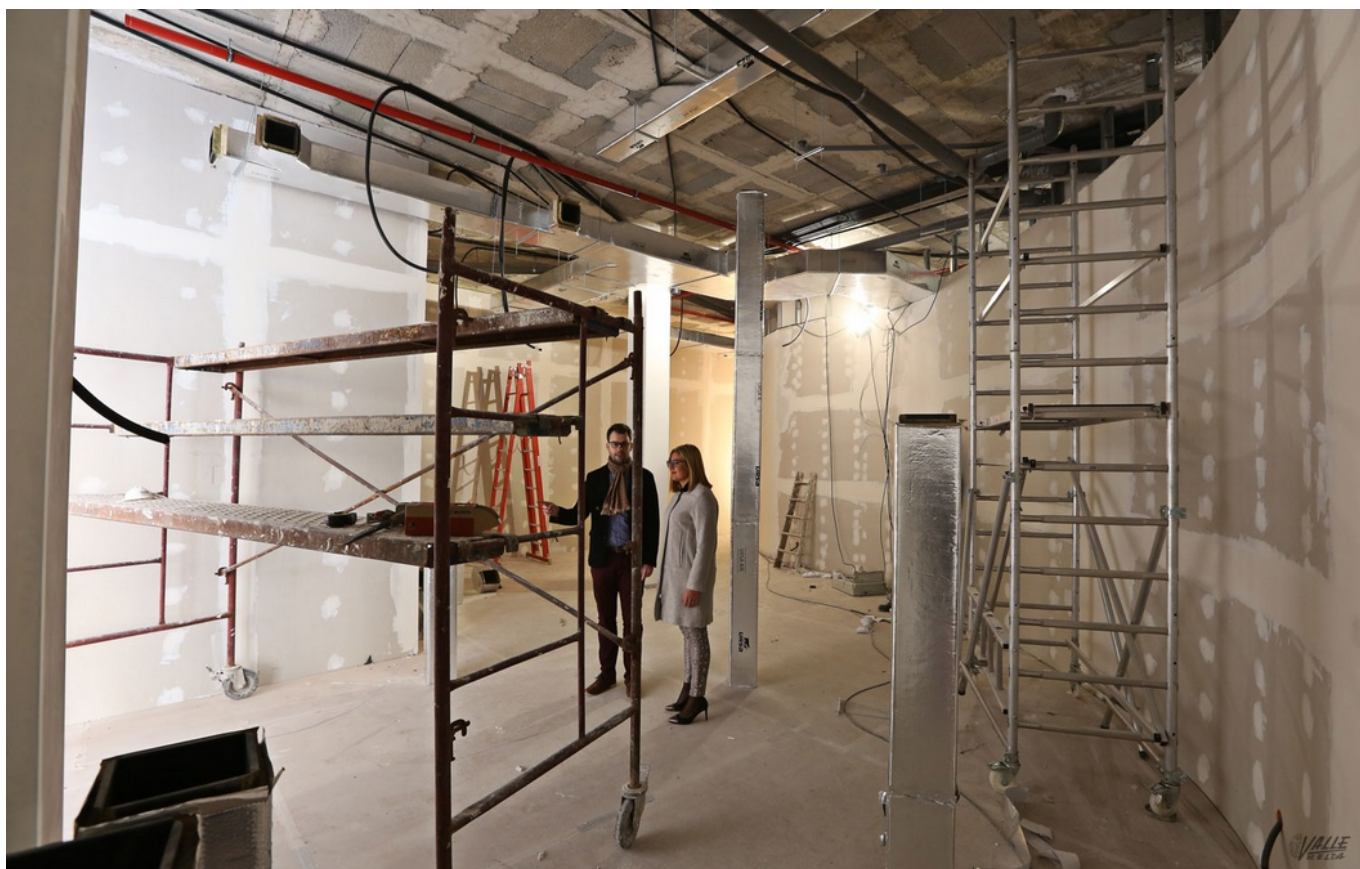
Las obras se están llevando a cabo desde esta misma semana | Jesús Cruces.
