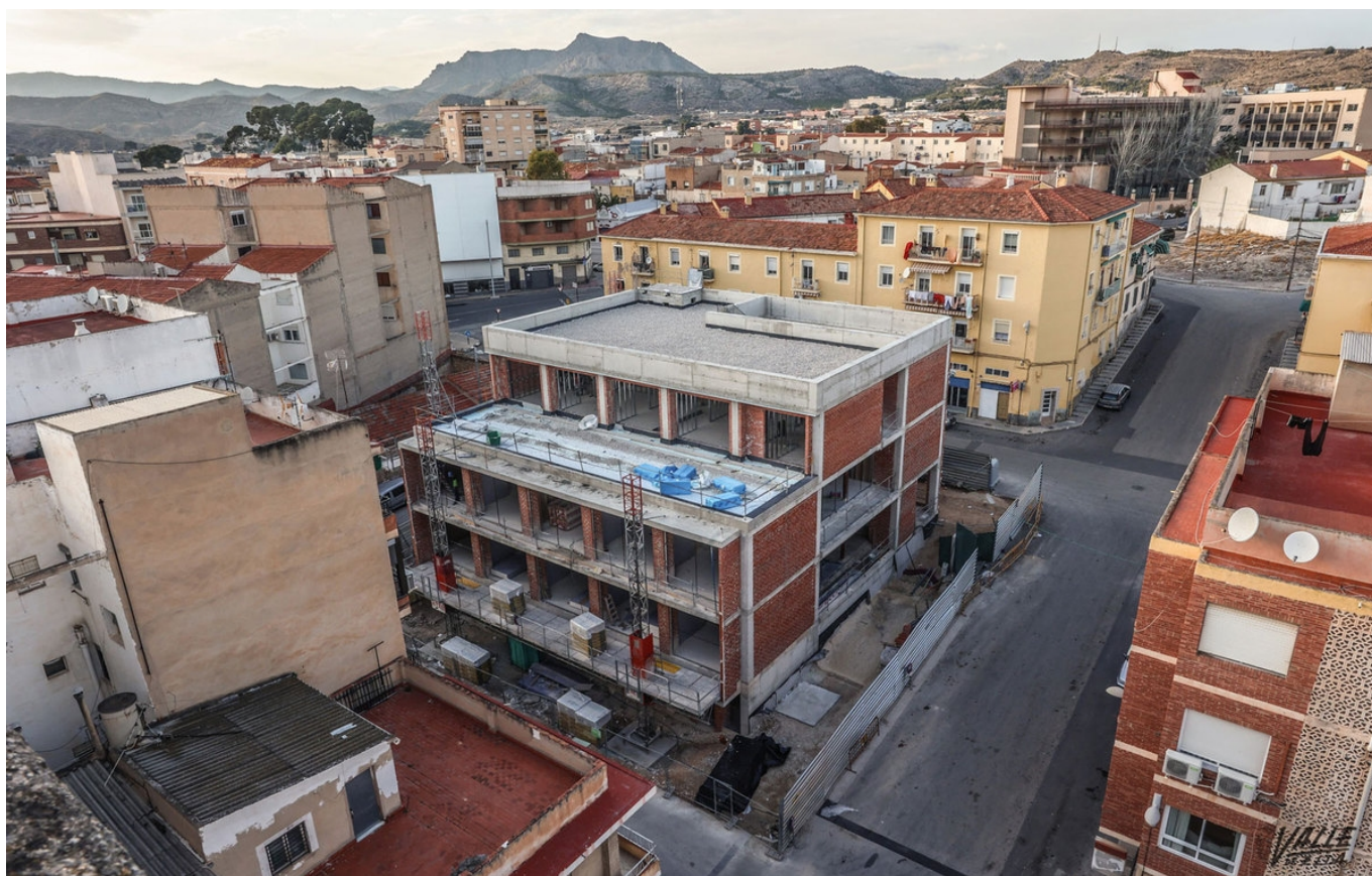
Las obras concluirán en el mes de septiembre | J.C.
