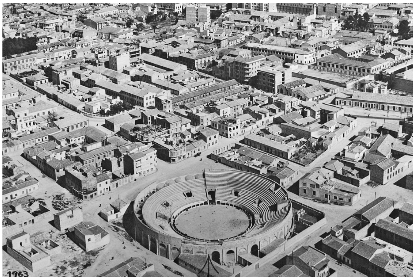
Vista aérea de la plaza de toros de Elda y barrios colindantes (1963)
